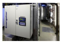
3. Das Herzstück der neuen Energiezentrale ist ein Elco-Blockheizkraftwerk, das 49 kW elektrische Leistung und 90 kW Nennwärmeleistung erzeugt. Damit deckt es 40 % des Strombedarfs sowie die Heizgrundlast ab.
