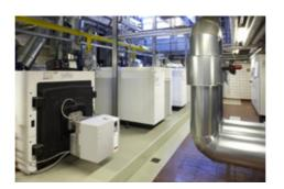
5. Als zusätzliche Absicherung und aufgrund hoher vorhandener Heizölreserven wurde zusätzlich ein Öl-Niedertemperaturkessel von Elco installiert. Die im Tryon MK378 integrierte Jetstream-Technologie verhindert Kondensation und eliminiert dadurch die Gefahr von Korrosionserscheinungen.
